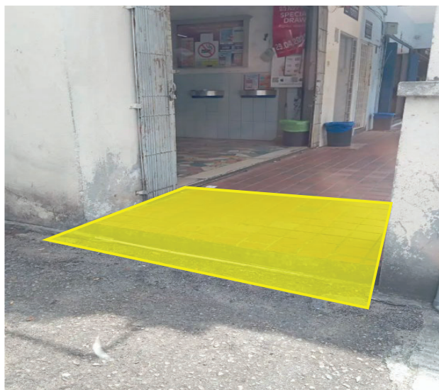
Pembinaan ramp dengan gradian 1:12 (drop 150mm, kelebaran 1200mm) berhadapan premis Agensi Nombor Nombor Ramalan Da Ma Cai (Lot 62750) Jalan PJS 8/4
